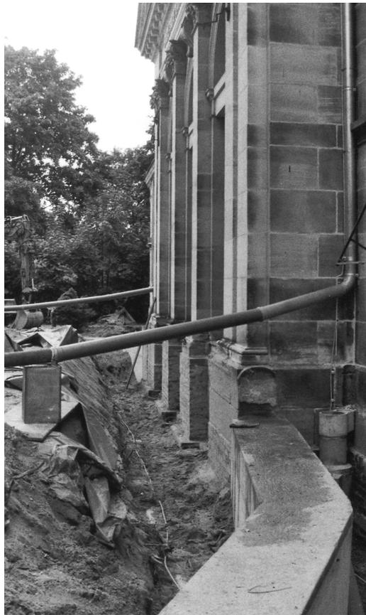
Im Herbst 2008 wurde das Fundament stabilisiert, ein Entfeuchtungsraben gelegt, und die zugewachsenen Grundleitungen wieder durchlässig gemacht.
