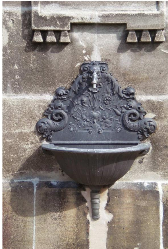
Die rostigen Außenbecken (links) wurden entrostet und ein Oberflächenschutz aufgebracht. Die Funktion dieser Becken werden im Zusammenhang mit den Beerdigungsriten erklärt.
