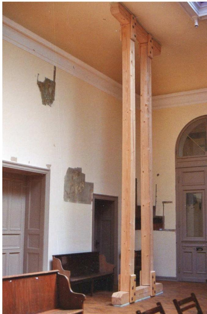
Bis zwei provisorische Stützpfeiler eingebaut, Maueranker zur Klammerung der Außenwände eingezogen, und die Dachkonstruktion gesichert waren, musste die Kultusgemeinde bei Trauerfällen in einen Nebenraum ausweichen.
