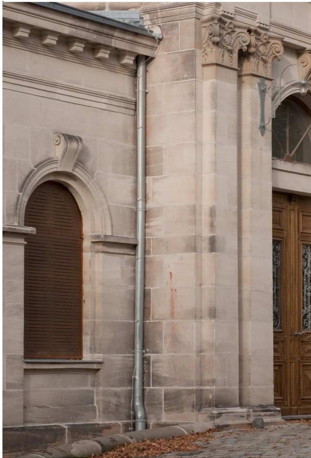
Nachdem das Dach repariert, Laub aus der Dachrinne entfernt, und eine Drainage gelegt war, wurde die Wand sichtbar trockener.
