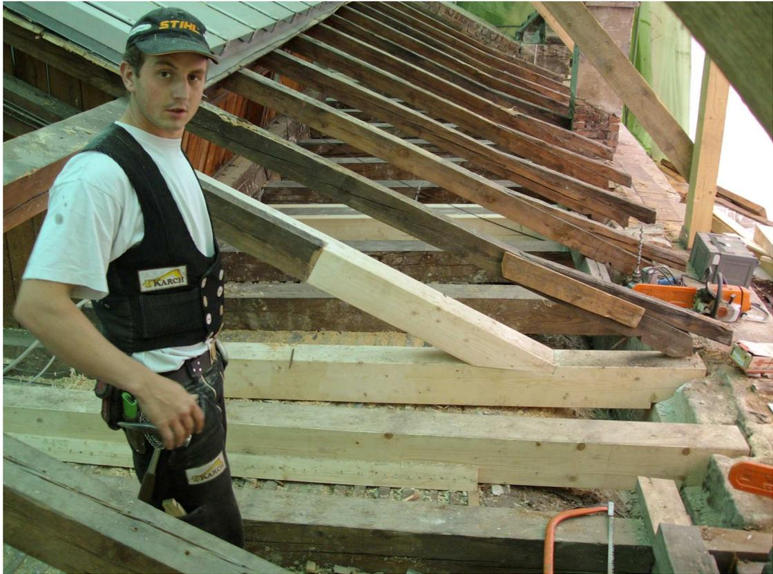
Die defekten Holzteile wurden auch entfernt und durch neue ersetzt.
