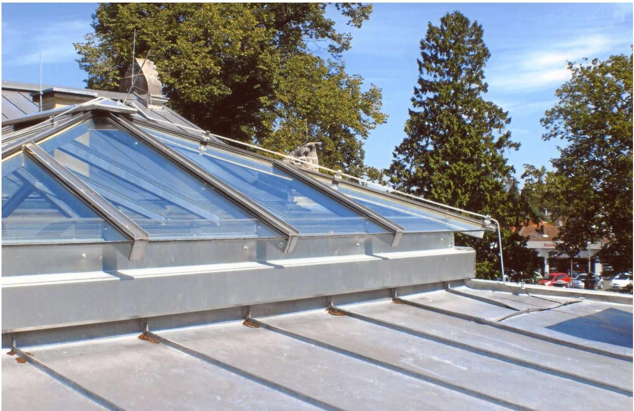
Als eine der ersten Maßnahmen wurden deshalb die Blechabdeckung und die Dachentwässerung, sowie die Blitzschutzableitungen erneuert.
